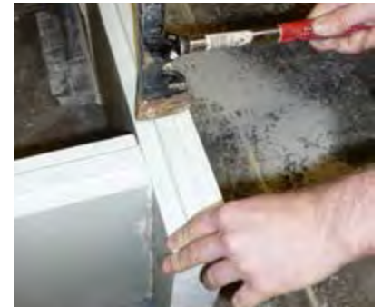
La photo montre comment recouper le tenon horizontal.
