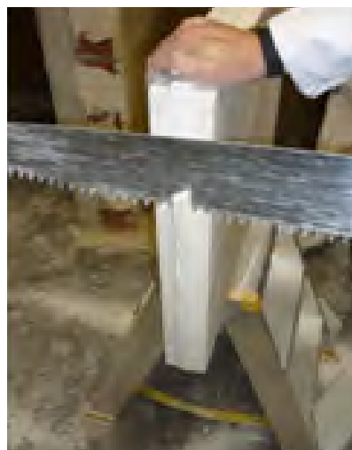
Exemple d'enlèvement d'un tenon à l'aide d'une scie ou d'une hachette de plâtrier
