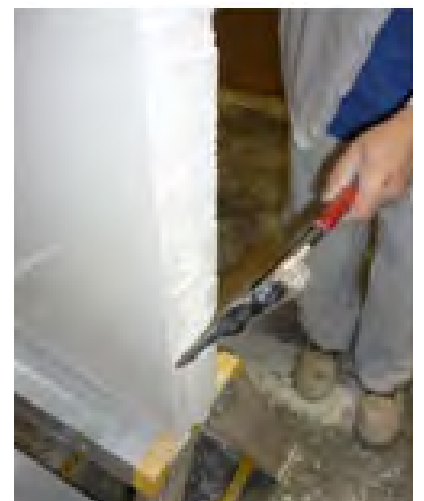
Exemple d'enlèvement d'un tenon à l'aide d'une scie ou d'une hachette de plâtrier
