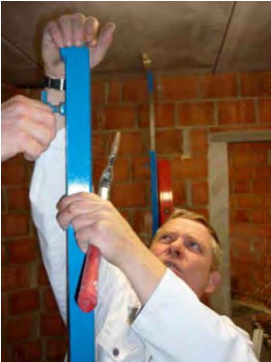
Réglage d'un étaçon à la bonne longueur Photo: J. De Schepper
