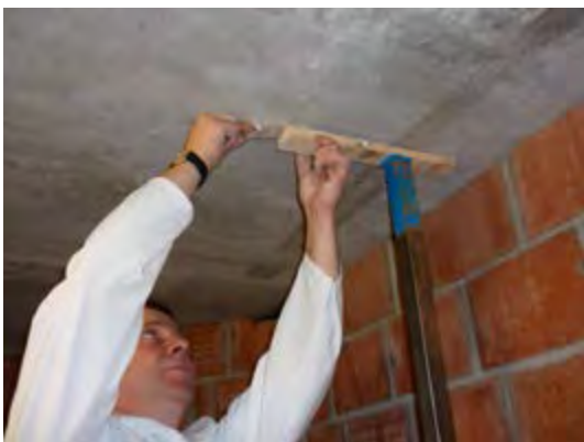
Placement d'un étaçon de référence Photo: J. De Schepper
