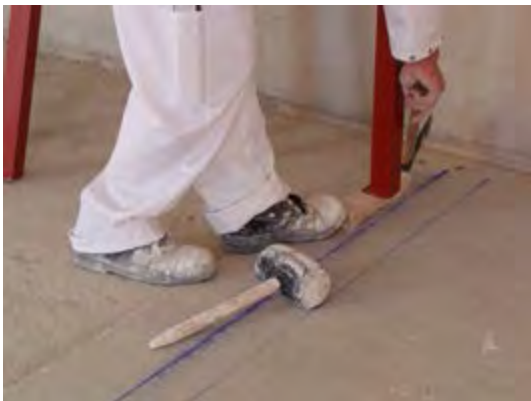
Placement d'éтанçons avec cales sous un gítage Photo: J. De Schepper
