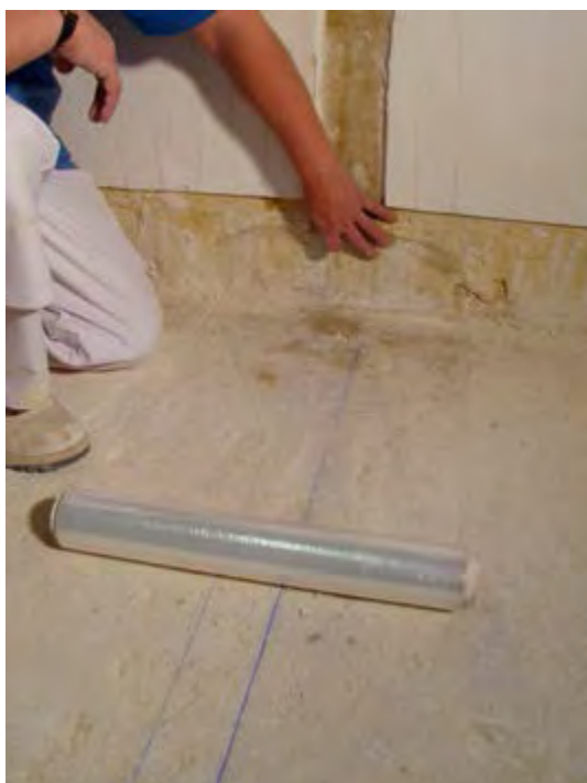
Placement du film Twee foto's: J. De Schepper
