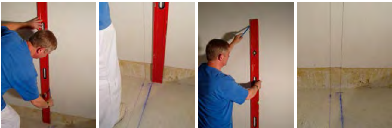
Traçage Vier foto's: J. De Schepper
