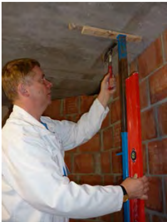
Placement d'un côté de l'étaçon à l'aplomb Photo: J. De Schepper
