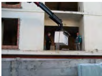
Placement pendant la phase de rénovation Photo: Isolava
