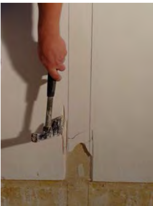
Préparation du raccordement vertical Vier foto's: J. De Schepper
