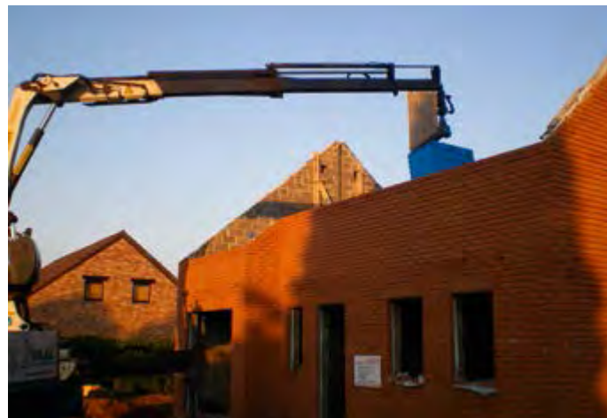
Placement pendant la construction du gros œuvre Photo: Isolava
