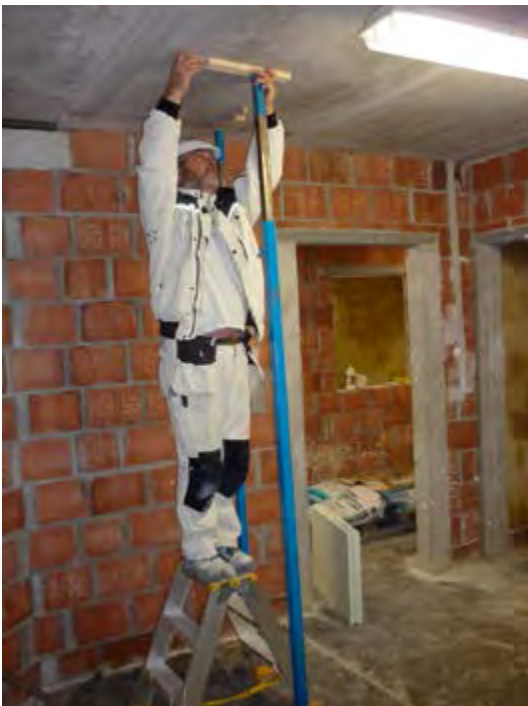
Fixation provisoire des étaçons Photo: J. De Schepper
