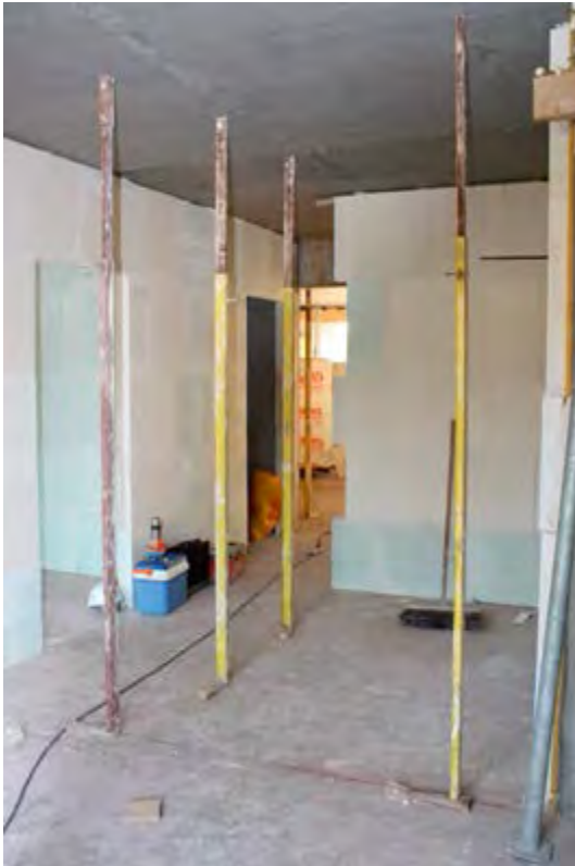
Placement d'un étançon avec latte de serrage au sol Photo: Promonta
