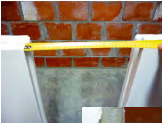
Mesurer une dimension intérieure Photos: Johnny De Schepper
