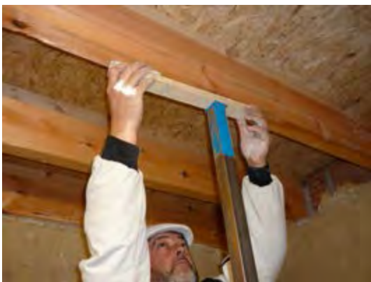
Placement d'un étaçon sous un gîtage Photo: J. De Schepper
