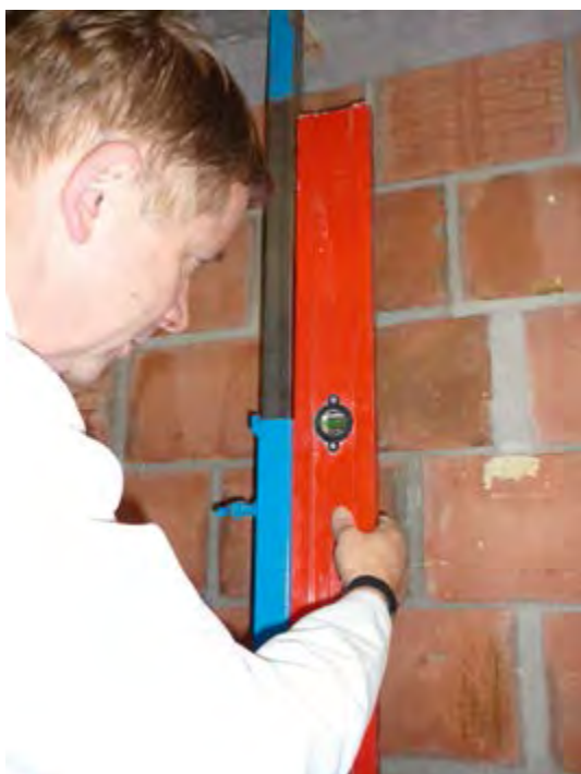
Placement à l'aplomb du deuxième côté de l'étaçon Photo: J. De Schepper
