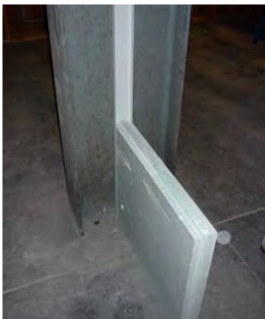
Raccordement contre une poutre Twee foto's: J. De Schepper
