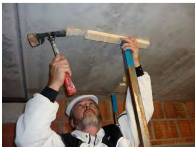
Réglage de l'étaçon Photo: J. De Schepper
