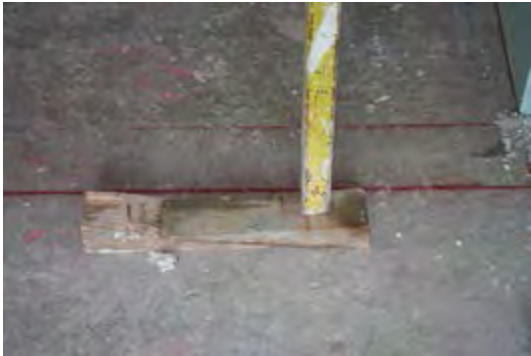
Placement d'éтанçons avec cales Photo: J. De Schepper
