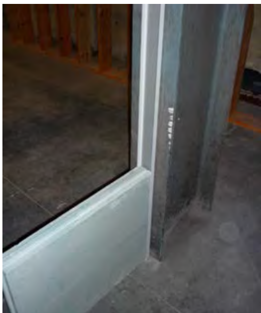
Raccordement contre une poutre Twee foto's: J. De Schepper
