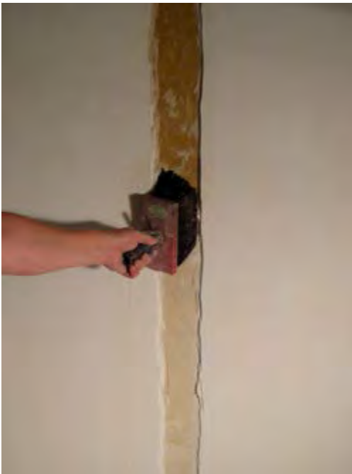
Nettoyer et préparer foto: J. De Schepper
