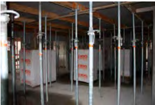
Placement pendant la construction du gros œuvre Photo: Promonta
