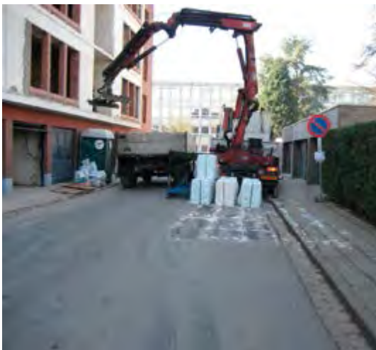
Placement pendant la phase de rénovation Photo: Isolava
