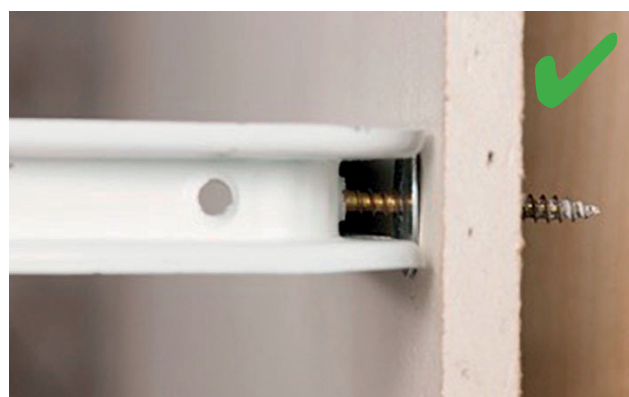
Simulation d'un contact total par ajout d'une rondelle
