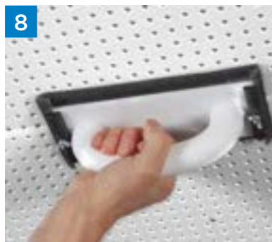
8 Après environ 12 - 24 heures, poncez les joints et les têtes de vis. Préparez pour la peinture.
