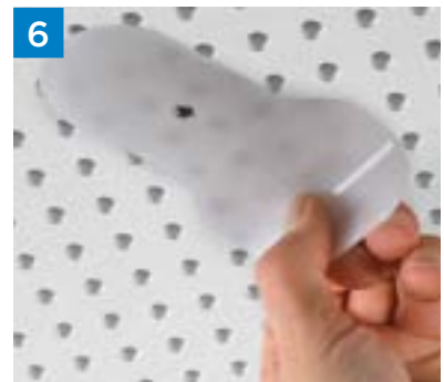
6 Jointoyez les têtes de vis avec le pochoir pour têtes de vis, en ménageant un petit supplément de hauteur.
