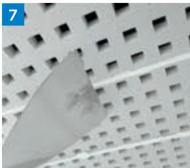
7 Après environ 30 minutes, éliminez consciencieusement la masse de produit de jointoiement excédentaire à l'aide de la spatule Rigitone® et lissez le joint.
